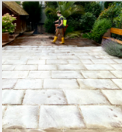
Behandlungsabfolge: Links der unbehandelte, verschmutzte Sandstein, in der Mitte die Reaktion der beiden Arvox-Komponenten kurz nach Auftrag und Einbürsten. Rechts die gereinigten, abgespülten und getrockneten Platten.
